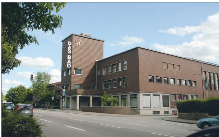
■ Das denkmalgeschützte, 2009 energetisch und technisch sanierte Bad an den Kaiserthermen in Trier; Fotos: Stadtwerke Trier
